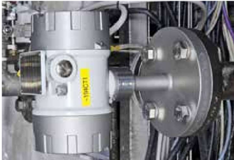
Instalação: Integração direta do sensor de imersão LiquiSonic® na tubulação principal.
