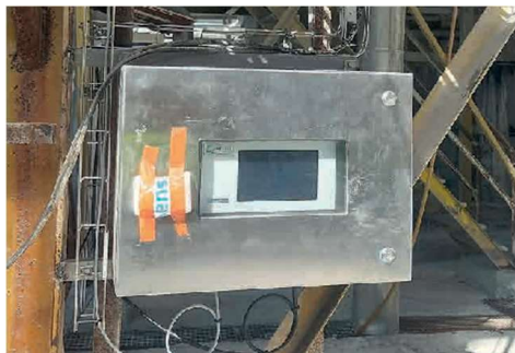
Instalação: LiquiSonic® Controlador instalado em invólucro de campo
